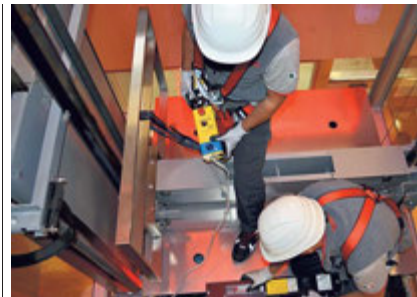
Tecnici al lavoro per installare un'ascensore
